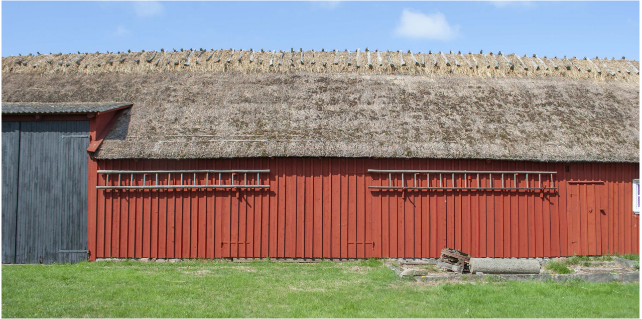
Ovan: Panelen har bytts på sydöstra ekonomilängans utsida. Till höger: brädorna på en port mot gården har bytts.
