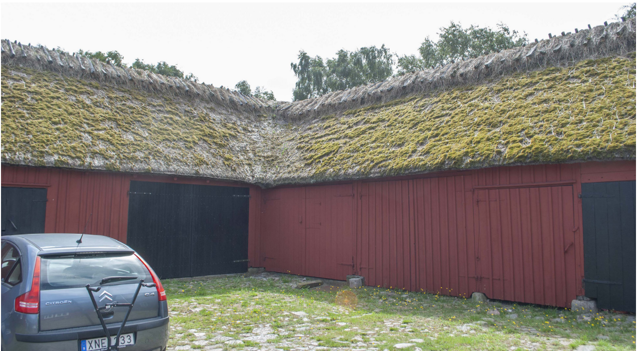
Alla tak, utom bostadshuset, har försetts med ny rygging.
