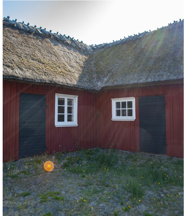
Den östra rännaldalen mot gården innan åtgärderna utfördes. Ryggningen var fortfarande i relativt gott skick i augusti 2020.
