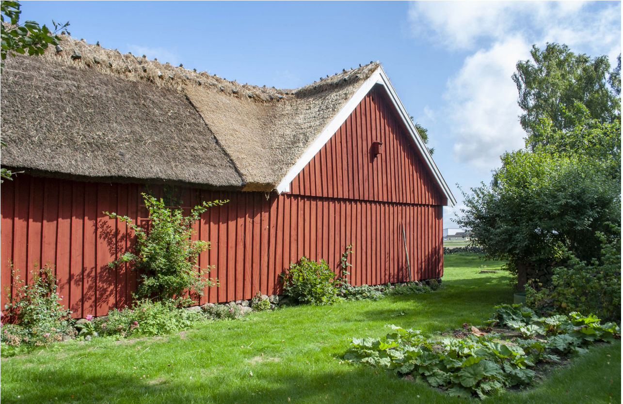
Rännalden i mötet mellan den sydöstra och sydvästra längan, mot trädgården, har lagts om.
