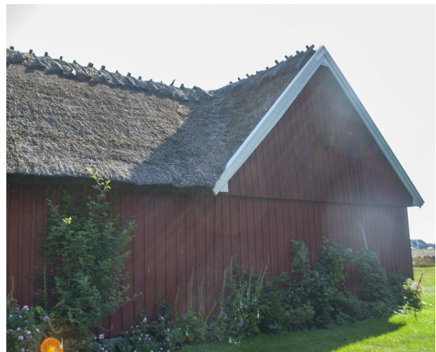
Rännaldalen i mötet mellan den sydöstra och sydvästra längan innan åtgärderna utfördes.
