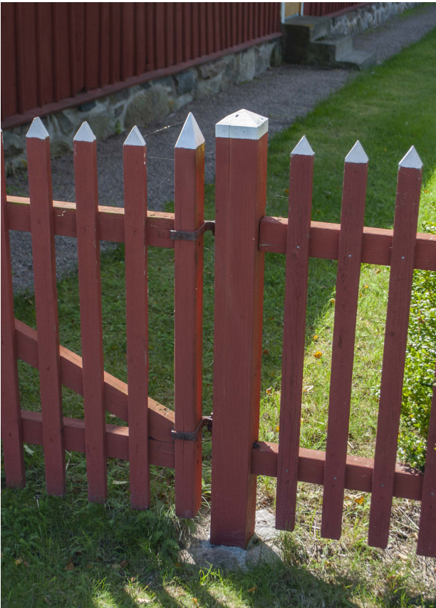
Delar av staketet har försetts med nya stolpar.
